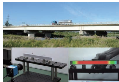
モアレ計測による橋梁モニタリング実験
