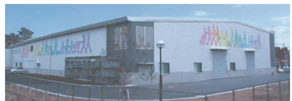
生活支援ロボット安全検証センター
