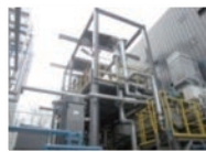
木質系バイオマス利用液体燃料製造プラント
