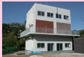
環境調和型 建材実験棟
