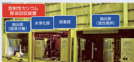
実証試験プラントの一部(福島県双葉郡川内村)
