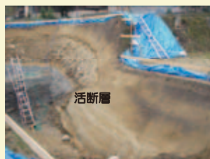
地震断層のトレンチ調査
