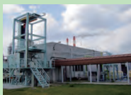
バイオマスプラント
