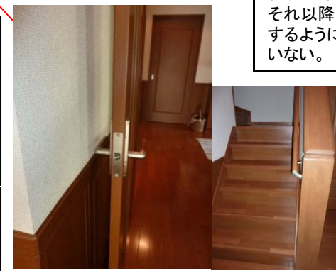
リビングと玄関の間のドアのノブ、階段手すり
