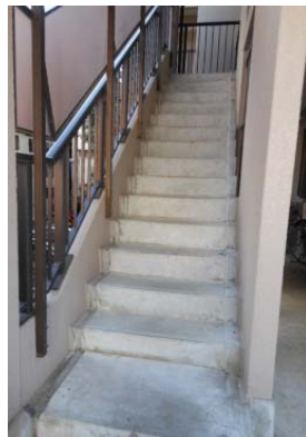
階段には手すりがない
