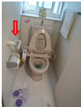
手すりつきトイレ
