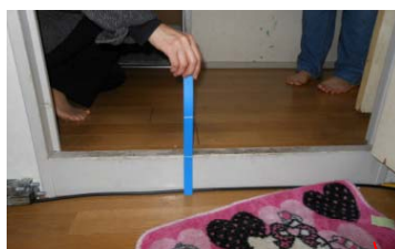
子ども部屋と廊下の段差(10cm)
