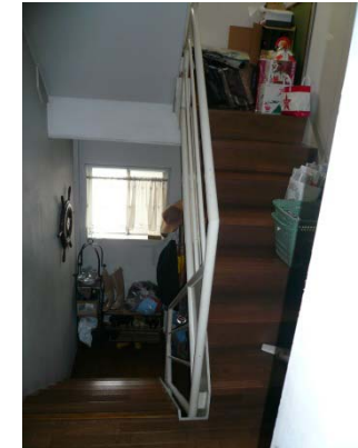
7階の階段。物がたくさん置かれているために、踏面が狭くなっている。
