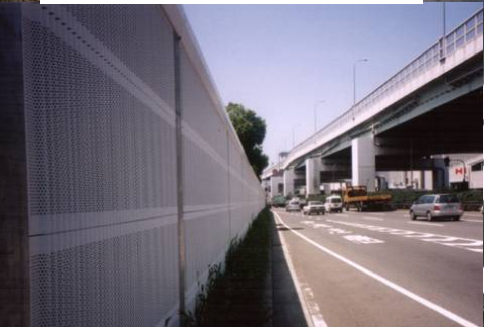
新型遮音壁(大阪府・泉大津市)
