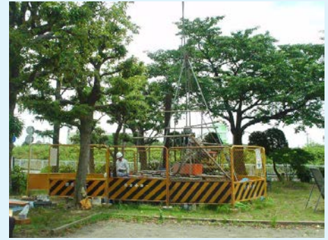
ボーリング調査現場
