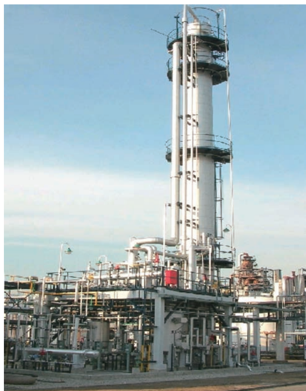
写真1 パイロットプラント（図1のユニットを7本内蔵） 丸善石油化学(株)千葉工場 2005.11
