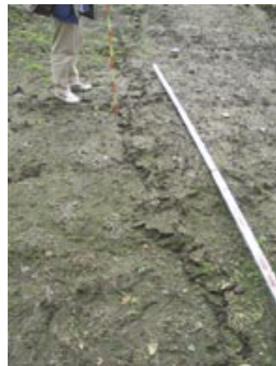
写真3 畑を横切る逆断層状の変形
