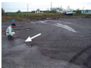
豊頃町大津港の津波の痕跡
