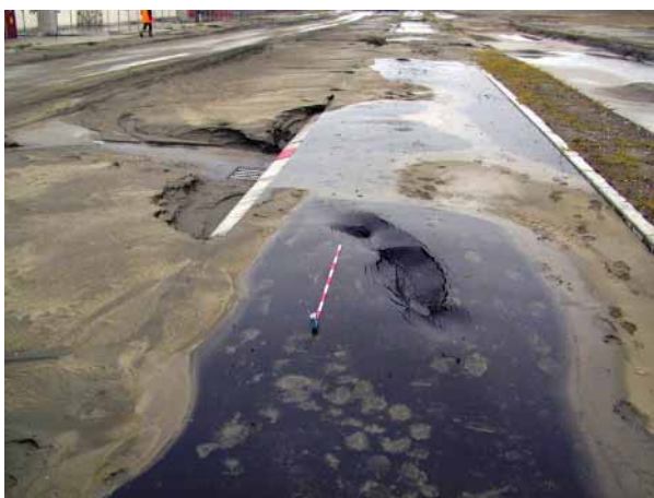
釧路西港第4埠頭の大規模な液状化
