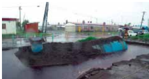
音別町風連の防火水槽の抜け上がり 地下3.9mに埋設されていた直径2.5m、長さ9mの防火水槽が抜け上がった。
