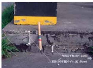
釧路西港第3埠頭のベルトコンベア脚部の抜け上がり
