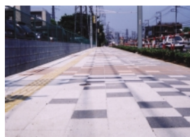
写真2 舗道に敷かれた光触媒材料
