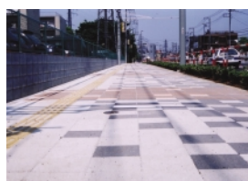
写真2 舗道に敷かれた光触媒材料
