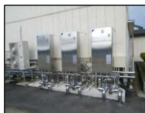
地中熱ヒートポンプ 3台
