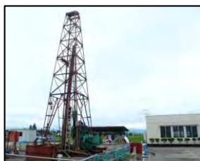
井戸掘削 Φ250×100m
