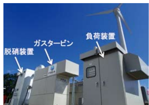
図3 アンモニアガスタービン
