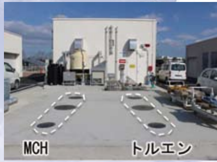
大型貯蔵タンク
