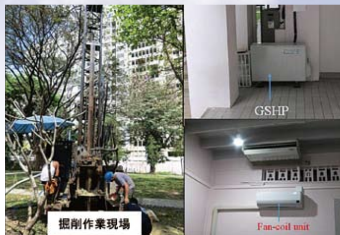
タイ・チュラロンコン大学に設置したGSHPシステム
