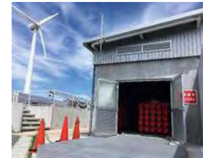
高圧水素設備外観
