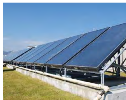
太陽熱集熱装置
