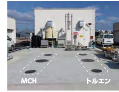
大型貯蔵タンク
