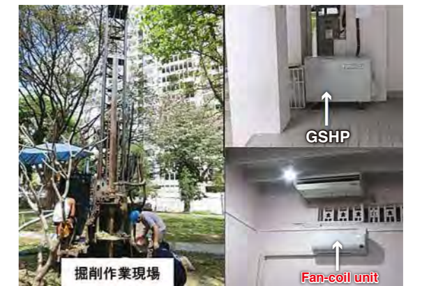
タイ・チュロンコン大学に設置したGSHPシステム タイ・チュロンコン大学の施設を利用して、バンコクでも地中熱システムによる冷房運転の可能性を実証しました。 ※GSHP: Ground Source Heat Pump (地中熱ヒートポンプ)の略
