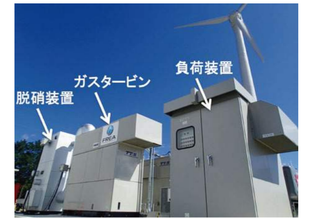
図3 アンモニアガスタービン
