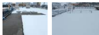
写真左：無散水消雪試運転の様子(2016/1/30) 写真右：昨年度消雪施設無しの様子(2014/12/17)
