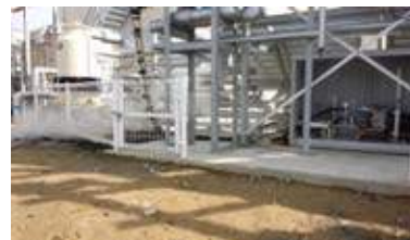
スクロール膨張機を用いた発電装置の実証実験の様子
