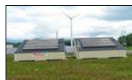
模擬屋根による試験環境設備
