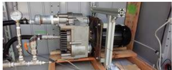
5kW級スクロール膨張機を用いた水蒸気発電試験機(動力部)
