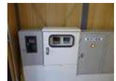
揚水量調整制御盤
